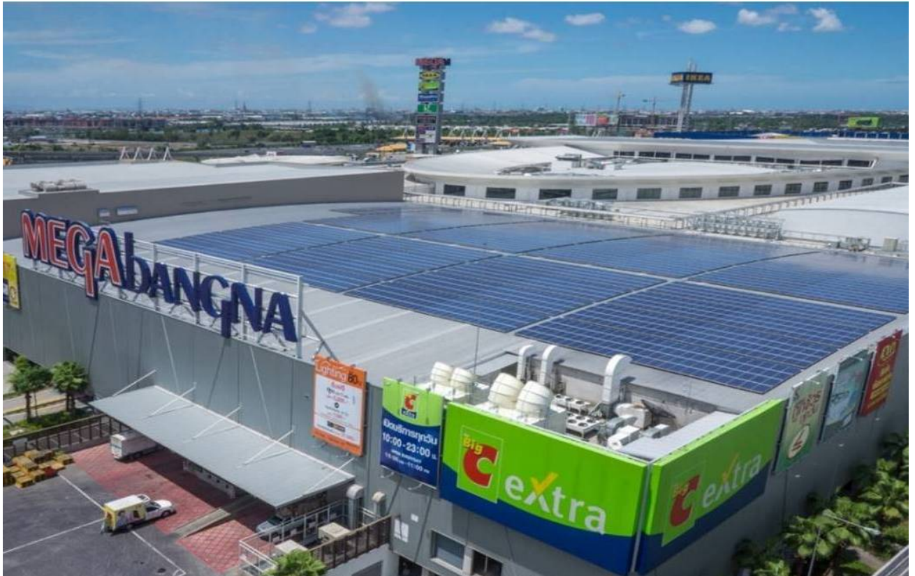
Bildunterschrift: Von Phoenix Solar geplant und gebaut; 1 MWp Photovoltaiksystem auf dem Dach der von IKEA Southeast Asia genutzten und betriebenen Shopping Mall Megabangna in Thailand. Abdruck frei, Beleg erbeten; Quelle: Phoenix Solar
